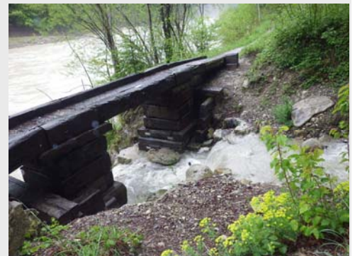
Der selbst gebaute Steg zum Schutz von Kröten
